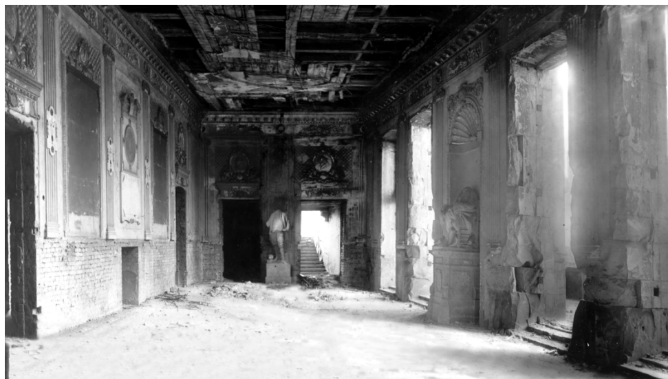
il.11. Rekonstrukcja fotograficzna wnętrza foyer na podstawie archiwalnych fotografii (D. Rzepliela, T. Wełna)
