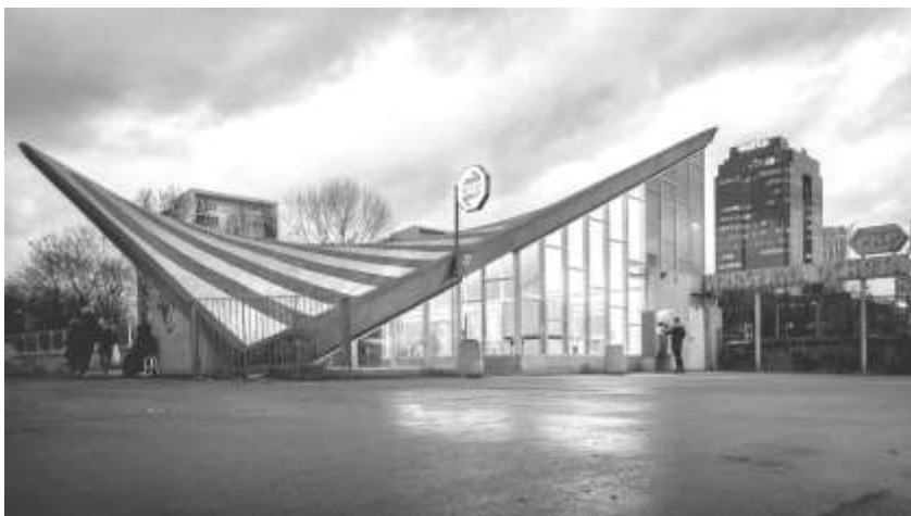
Rysunek 5. Budynek dworca Warszawa-Ochota widziany z Al. Jerozolimskich 27
