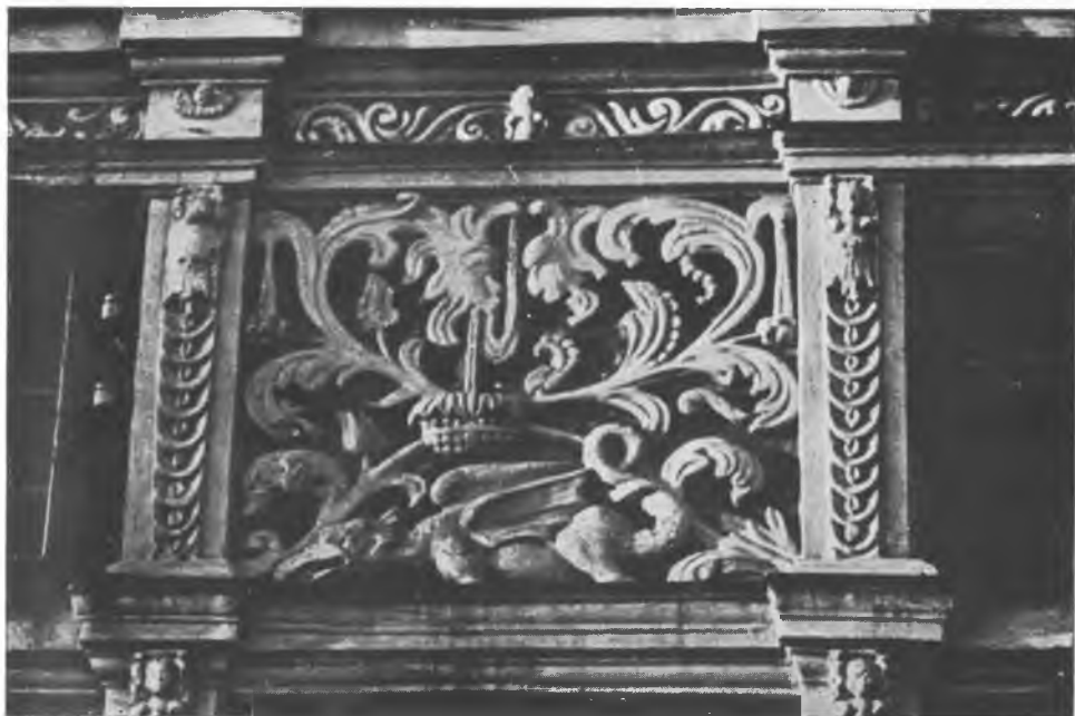
Ryc. 7. Ornament na fasadzie kamienicy „Pod lwami“ w Zamościu (fot. Jerzy Żurawski)
