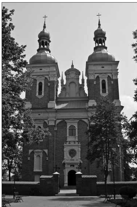
2. Fasada kościoła parafialnego w Gołębiewie, fot. A. Stankiewicz
