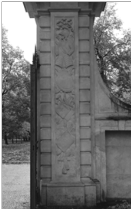
4. Pałac w Wilanowie, brama główna, filar południowy; fot. autor
