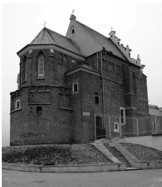
10. Kaplica Trójcy Świętej w Lublinie, elewacja północno-wschodnia, 2012
