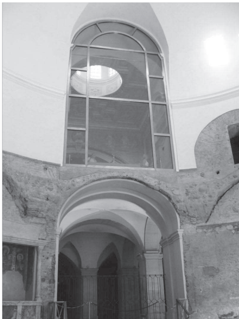
8. Rzym, bazylika świętych Kosmy i Damiana - widok z rotundy w kierunku absydy, 2009, fot. M. Szymaszek
