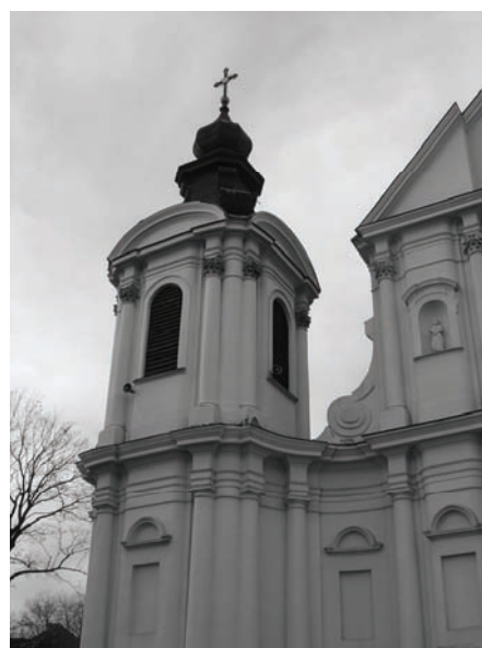
3. Leśna Podlaska, wieża południowa (fot. M. Iwanek)
