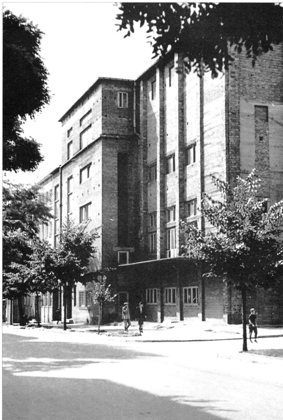
5. Widok fasady Biblioteki z lat pięćdziesiątych
