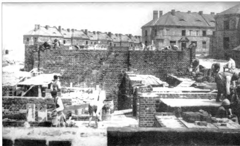
16. Budowa osiedla mieszkaniowego, widok na budynki typu VII i II – 1930 r.
