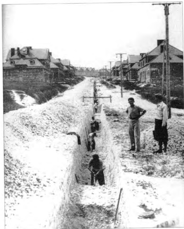
17. Budowa obiektów Dyrekcji w Chełmie, ul. Stephensona – Limanowskiego – 1932 r.
