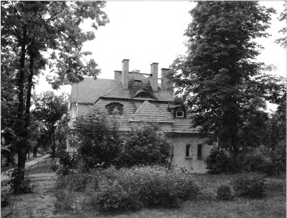
33. „Dyrekcja”, Chełm, budynki stylu dworkowego w otoczeniu przydomowych ogrodów
