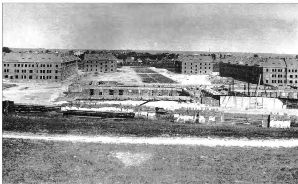
20. Budowa gmachu Dyrekcji i budynków na osi alei J. Piłsudskiego, widok z Góry Kredowej – 1929 r.
