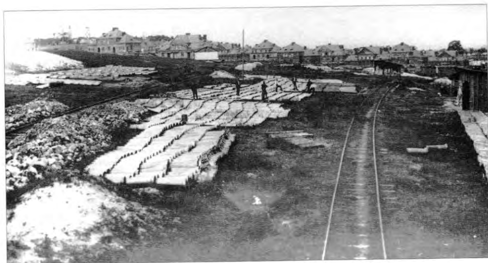
18. Budowa obiektów Dyrekcji, plac składowy – 1932 r.
