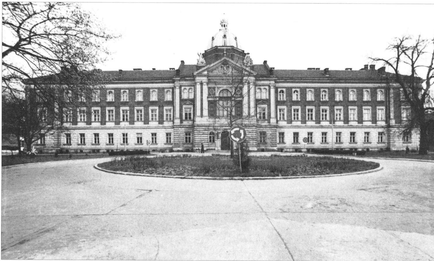
5. Elewacja frontowa budynku głównego – stan obecny
