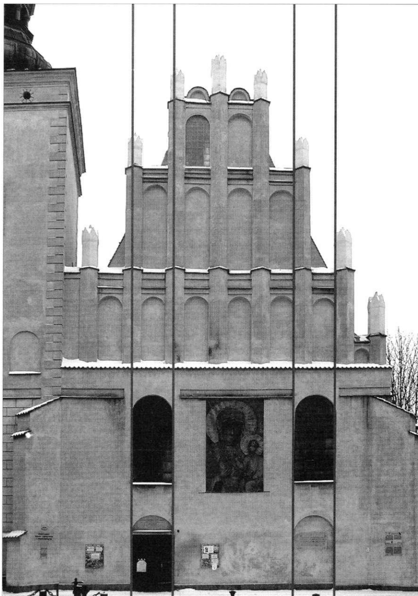
1. Fasada kościoła Brygidek (bez skrótu perspektywicznego). Zaznaczono linie krawędzi okien i kontur okna nawy północnej nałożony na lewą górną blendę szczytu (zmniejszony do 60%). Oprac. M. Kurzej
