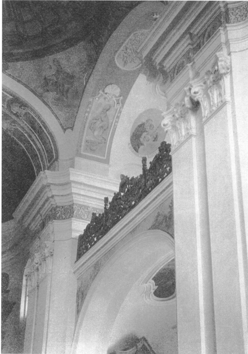
4. Widok na partię emporową
