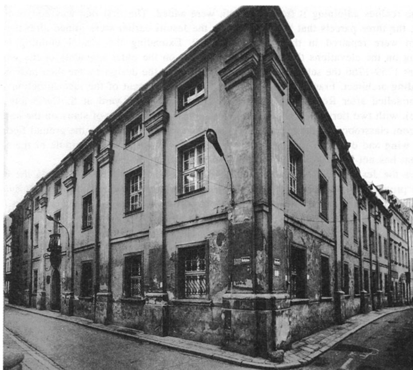
2. Poznań, dawna szkoła jezuicka, widok z południowego wschodu
