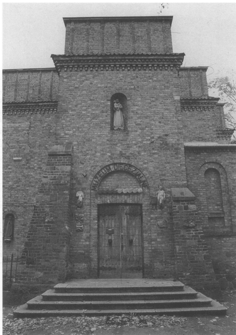
3. Widok obecny – elewacja zachodnia, Fot. Dorota Sobieraj
