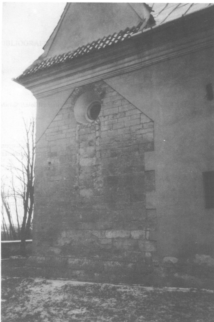
15. Zawichost-Trójca. Kościół p.w. Świętej Trójcy – widok prezbiterium od strony wschodniej, XII-wieczna technika budowlana, widoczne zamurowanie pierwotnego okna romańskiego. Fot. W. Koziejowski, 1993.
