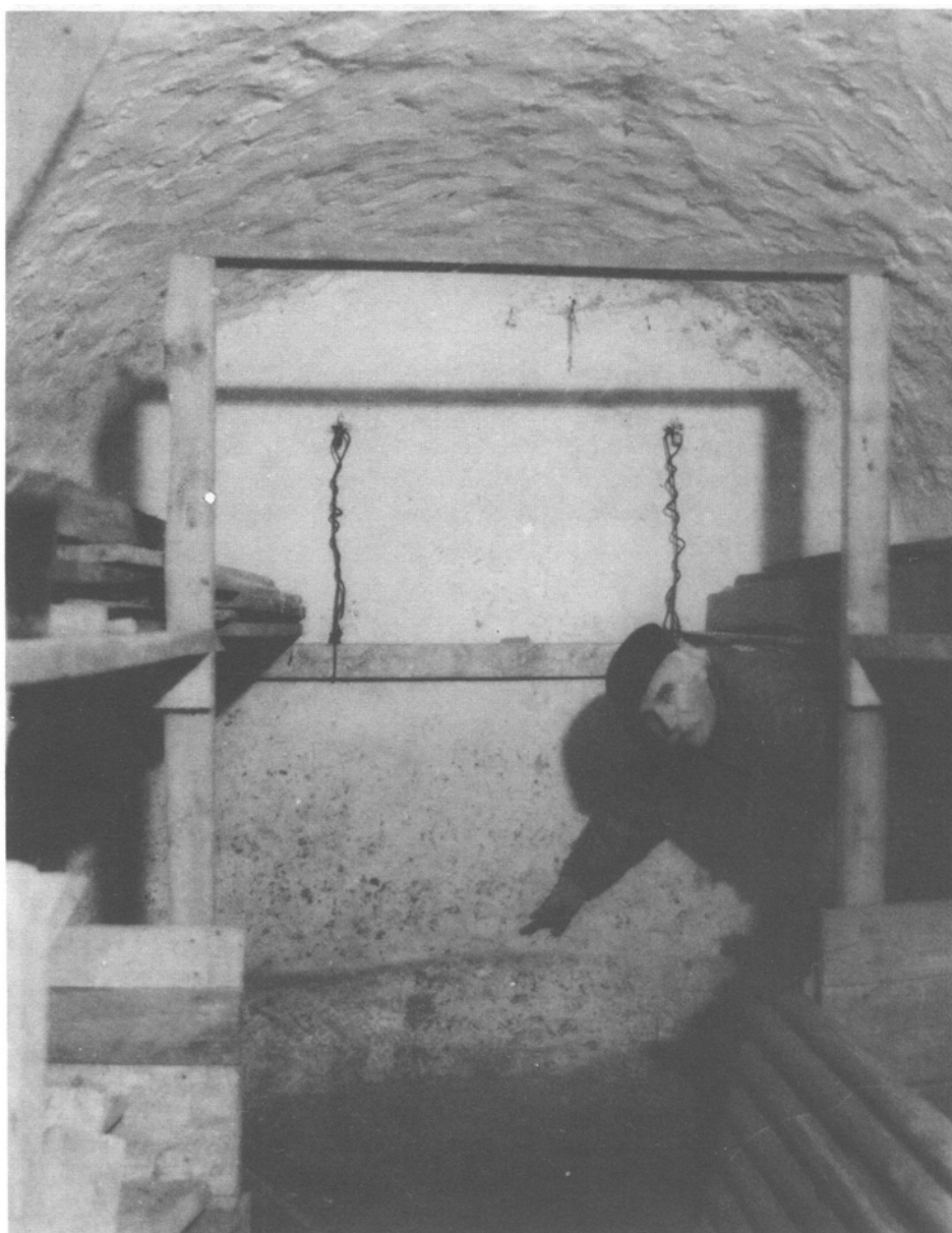
12. Zawichost. Relikty budowli na krawędzi skarpy (poz. 2 na il. 7), ujawnione przez autora we wnętrzu piwniczki, widoczne dolne partie budowli półokrągłej (apsyda?, rotunda). Fot. Z. Puławski, 1994.
