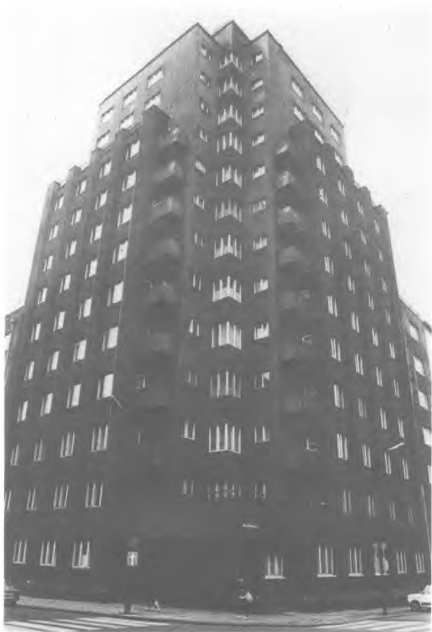
Il. 7. Wieżowiec 17-kondygnacyjny, Katowice. Fot. M. Czarnacki
