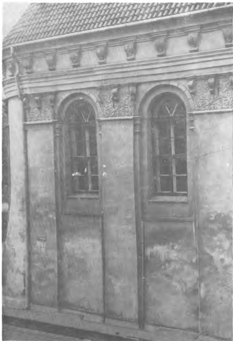
Il. 13. Elewacja boczna kościoła św. Wojciecha
