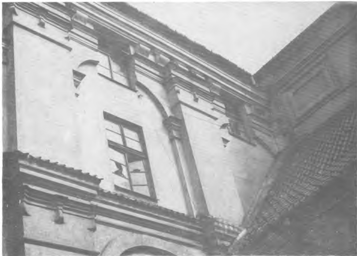
Il. 23. Elewacja boczna kościoła pofranciszkańskiego w Lublinie z lat 1635-1644
