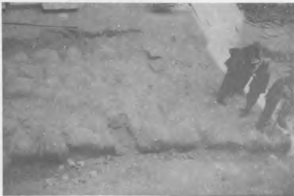
2. Fundamenty gotyckie odsłonięte pod ul. Świętojańską w 1956 r., założone przypuszczalnie w końcu XIV w. pod mury przewidzianej wieży zachodniej kościoła św. Jana w I fazie budowy Fot. autor
