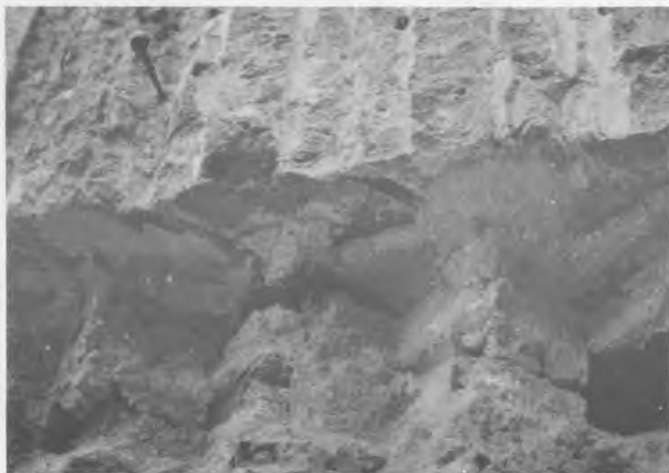
16. Fragment ościeża łuku tęczowego. Gotyckie cegły profilowane obtłuczone podczas restauracji Idżkowskiego
