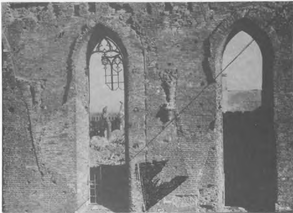
14. Fragment ściany nawy południowej katedry św. Jana, stan w 1948 r. Widoczne: trójkątne wnętrza przygotowane do sklepień i słupek (I faza), następnie zamurwane, oraz pozostałości tzw. stopek sklepień (II faza), ponadto przemurowania okien z ich przesunięciem – z okresu restauracji Idżkowskiego
