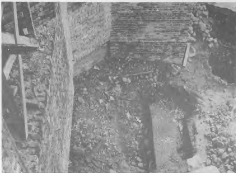
3. Odsłonięty fragment rozpoczętej w końcu XIV w. ściany zachodniej kościoła św. Jana w I fazie budowy Fot. autor
