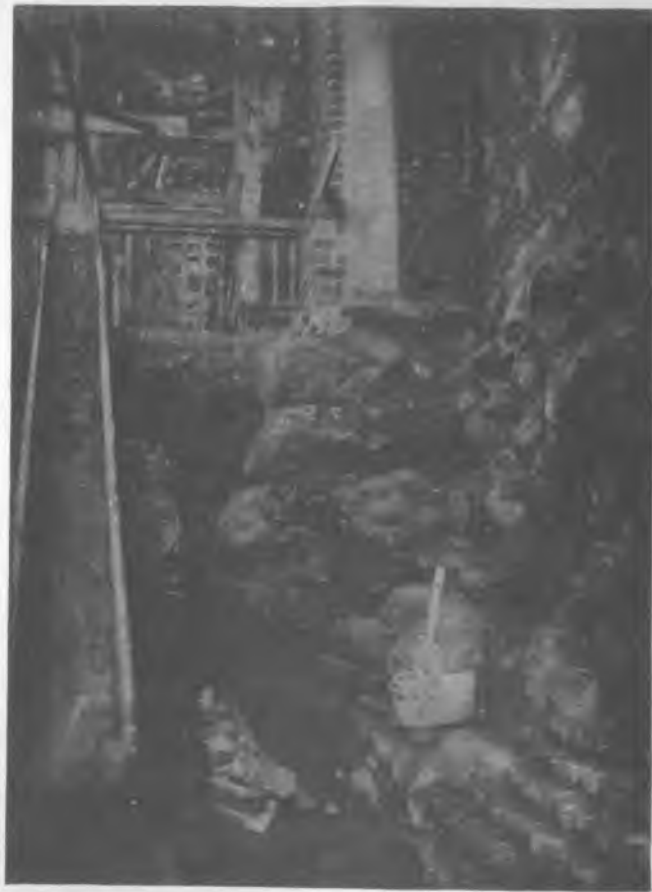
7. Odsłonięty fundament północnego węgara łuku tęczowego nie mający kontynuacji pod łukiem
