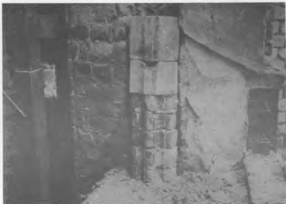
17. Fragmenty laskowań gotyckich w prezbiterium, nawarstwionych w I i II fazie budowy
