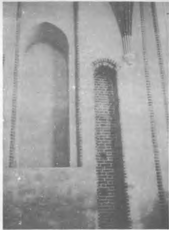
11. Północna ściana prezbiterium katedry św. Jana. Nisza Najświętszego Sakramentu oraz dawny otwór oratorium na piętrze (przypuszczalnie kaplicy mansjonarzy). Stan po odbudowie.
