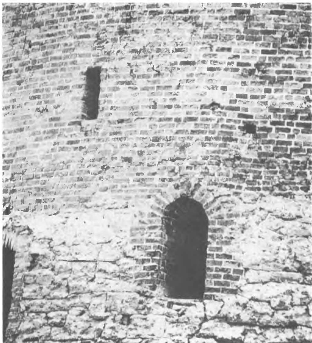
2. Wieża na zamku lubelskim, fragment elewacji od strony północnej. Widoczne okno strzelnicze i podwójne rozglifione okno oświetleniowe II kondygnacji (otwór widoczny w lewym narożniku ilustracji wybity później
