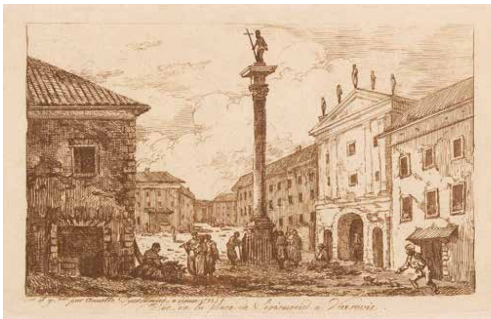
8. Akwaforta z przedstawieniem placu z kolumną Zygmunta III Wazy; strona 6 albumu Vues de Pologne , egzemplarz A w zbiorach Muzeum Narodowego w Warszawie; fot. MNW
