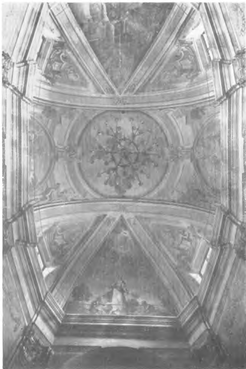
10. Kościół popauliński we Wrocławiu. Sklepienie nawy
