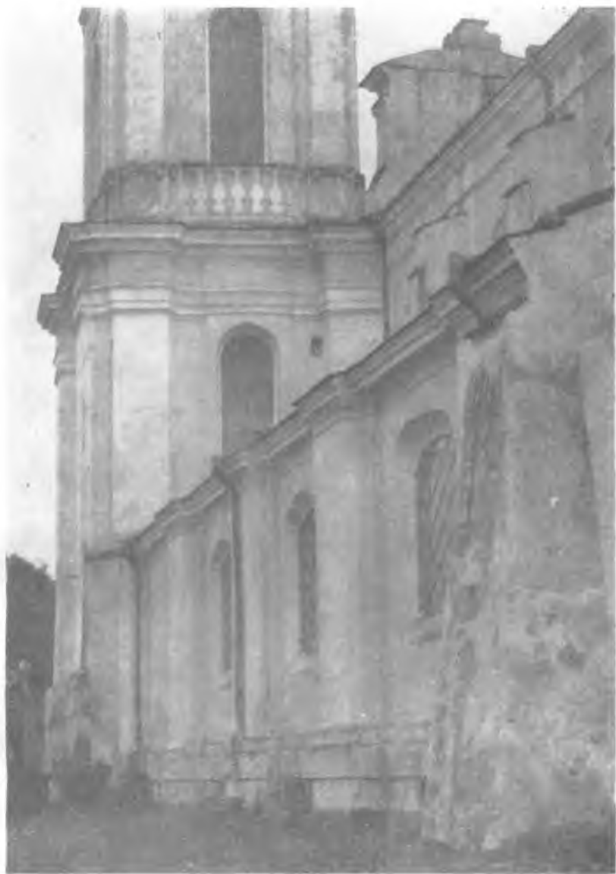
Ryc. 6. Kościół w Woli Gułowskiej. Widok na południową nawę boczną i wieżę.
