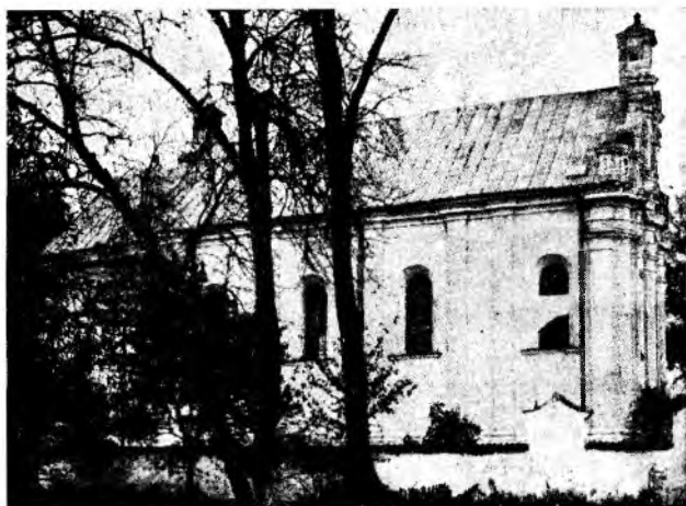
Ryc. 30. Kościół w Baranowie. Elewacja północna.
