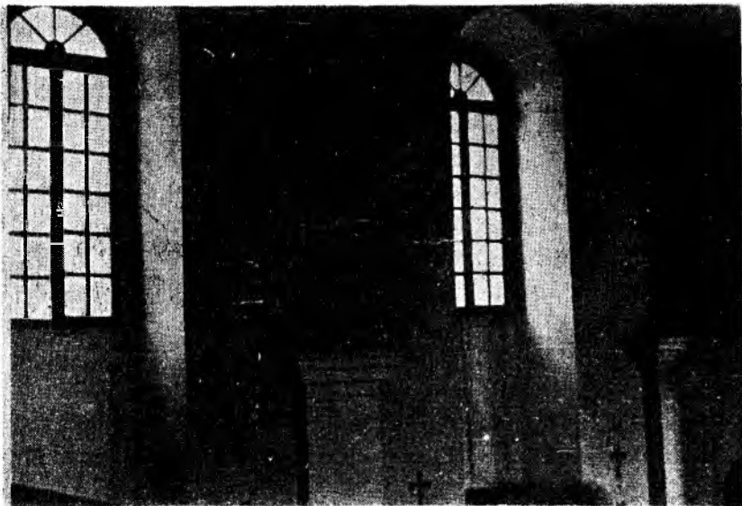
Ryc. 5. Kościół św. Ducha w Markuszowie. Ściany nawy północnej.
