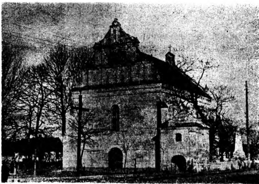
Ryc. 2. Kościół św. Ducha w Markuszowie. Widok od strony fasady.
