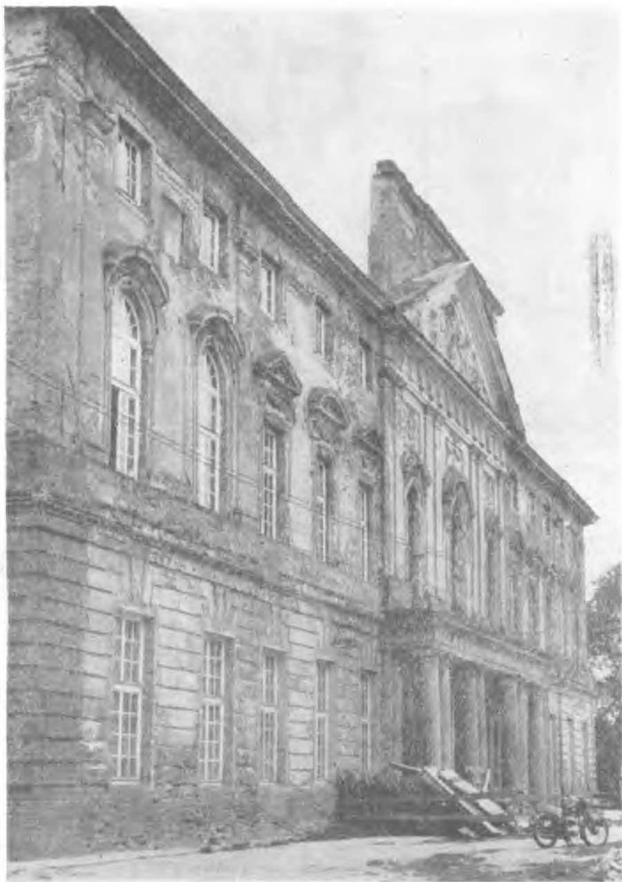
Ryc. 4. Pałac w Lubartowie. Fasada. Stan z 1961 r.
