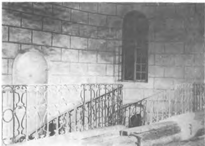
Ryc. 22. Klatka schodowa (piętro).
