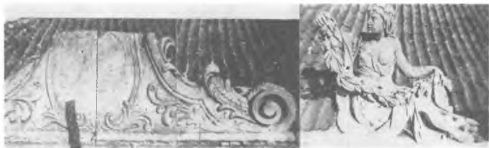
Ryc. 16. Attyka bocznego ryzalitu fasady.
