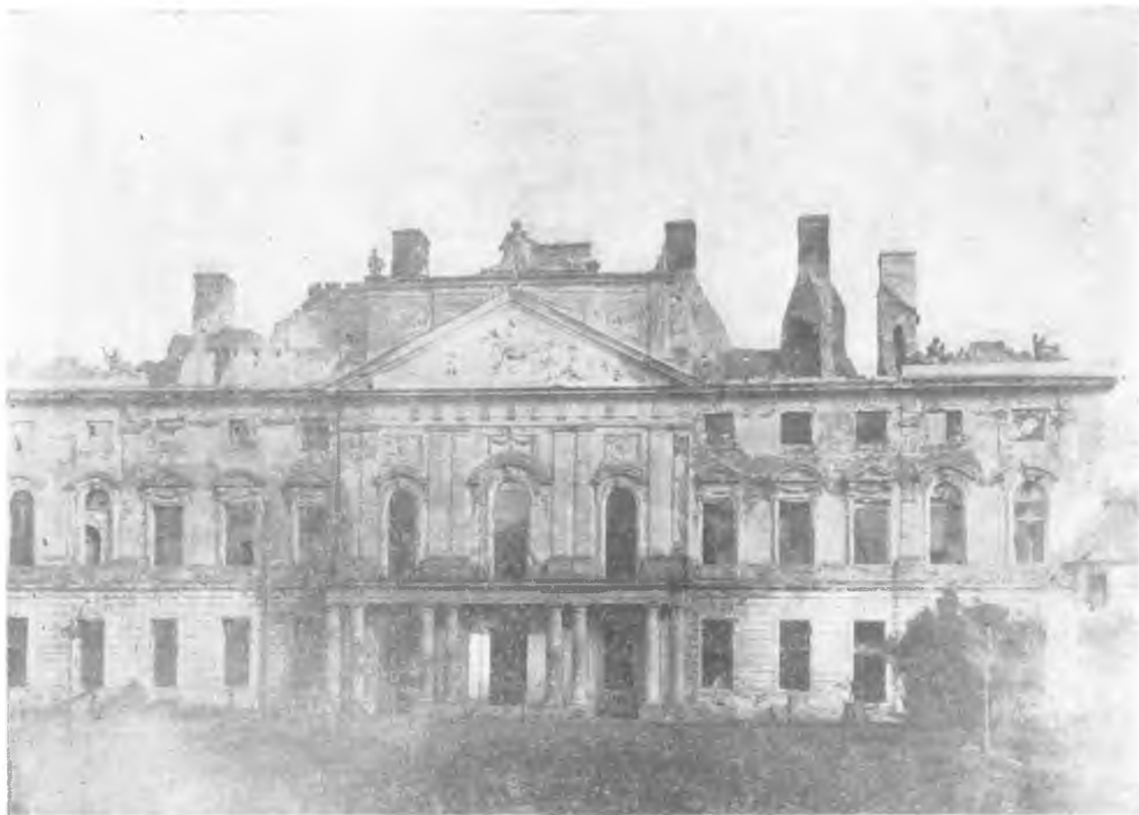
Ryc. 3. Fasada pałacu w Lubartowie. Stan po pożarze 1933 r.
